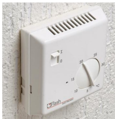
Bouton à droite : vérifier à travers les trous d'aération supérieurs la couleur du composant
